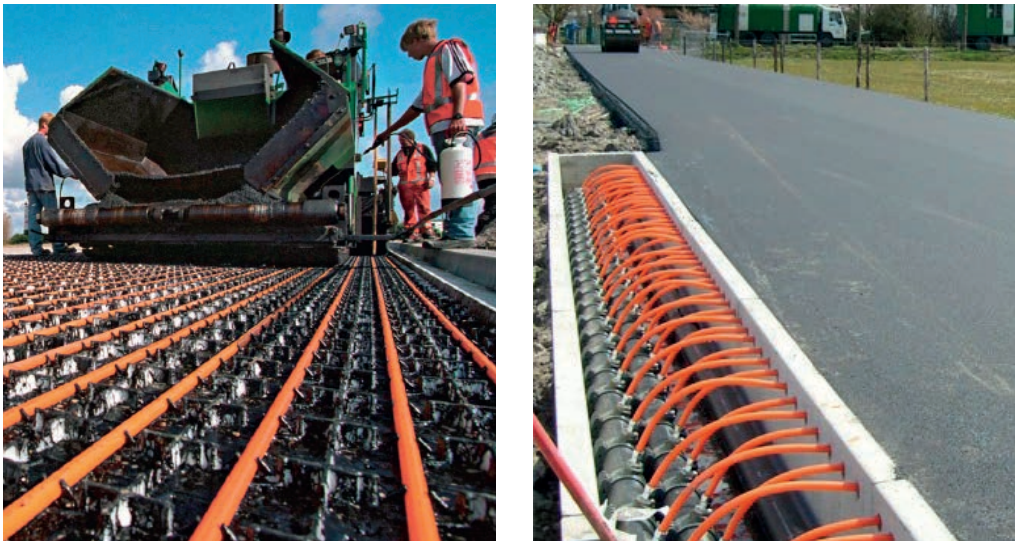
Figuur 2 - Asphaltcollectoren tijdens en na aanleg van het wegdek. Middels asphaltcollectoren kan warmte uit het asfalt gewonnen worden. De collectoren worden in een tussenlaag van het wegdek opgenomen. De bovenste asfalt laag kan voor onderhoud vervangen worden zonder dat dit schade aan de collectoren veroorzaakt. Door de donkere kleur van het asfalt kan het systeem 's zomers relatief hoge temperaturen opwekken. Deze warmte dient opgeslagen te worden voor benutting in de winter. (Bron: https://ooms.nl/specialismen/energie-uit-asfalt/ )
