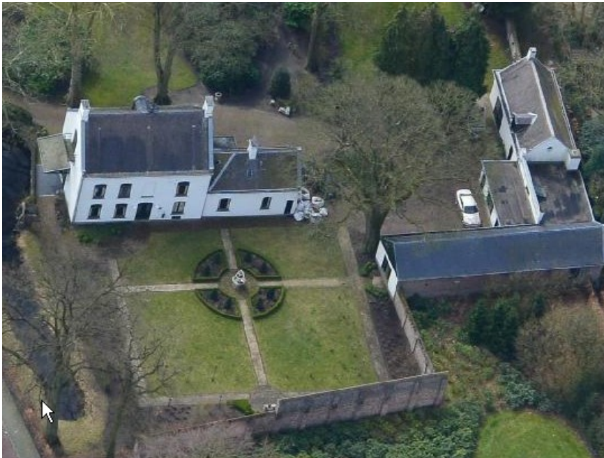
Het complex Agnetendal in Dommelen vanuit de lucht gezien.
