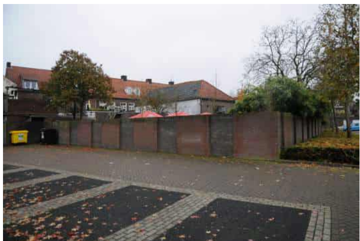
huidige situatie rondom het tuinterras Du Commerce
