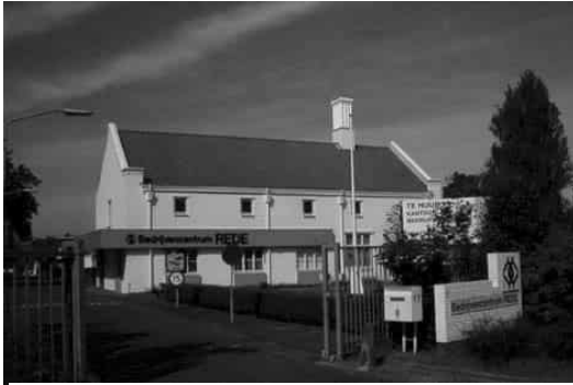
Het REDE-terrein; locatie waar in de toekomst woningbouw gerealiseerd wordt
