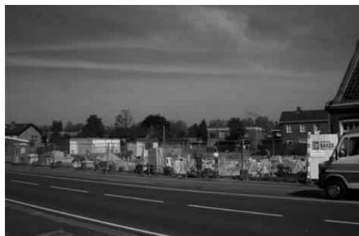
Inbreidingslocatie aan de Dommelseweg, start bouw appartementen.
