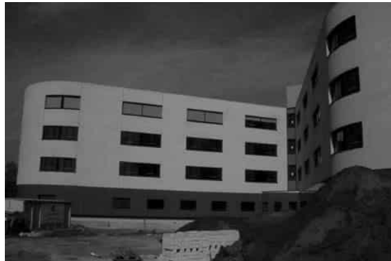
Kempenhof; verpleeg- en verzorgingshuisplaatsen in aanbouw.
