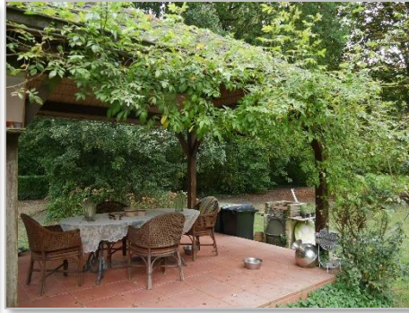
Te slopen aanbouw
