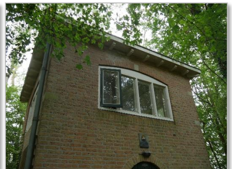
Te behouden torenvormige schuur (optie voor compensatie vleermuizen)
