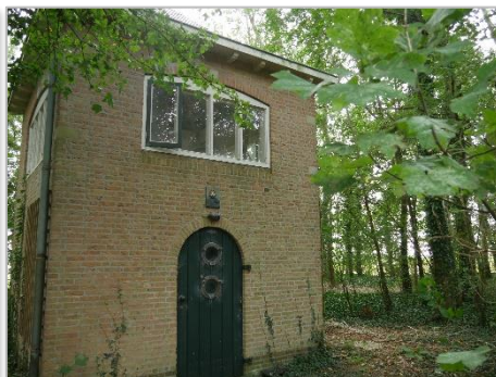
Te behouden torenvormige schuur (optie voor compensatie vleermuizen)
