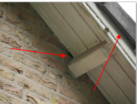
Te slopen uitbouw (slaapkamer) Rode pijlen = potentiële verblijfsplaatsen vleurmuizen
