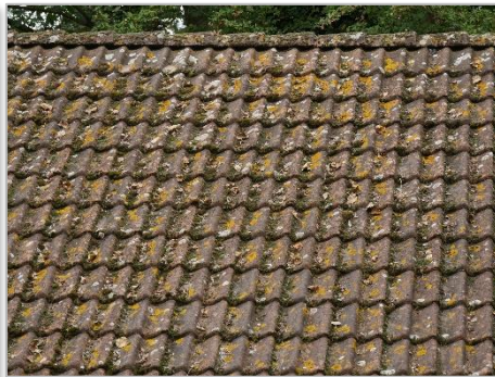
Dak te behouden garage (niet toegankelijk voor vleermuizen)
