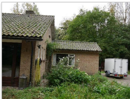
Bestaande inpandig aan te passen woning met te slopen uitbouw (slaapkamer)
