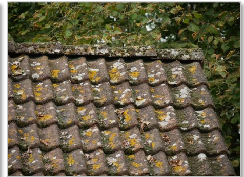
Dak te behouden garage (niet toegankelijk voor vleermuizen)
