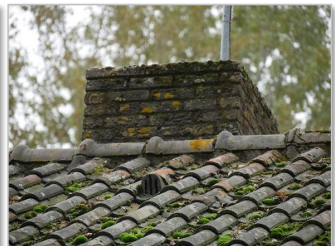
Dakbedekking inpandig aan te passen woning (niet toegankelijk voor vleurmuizen)
