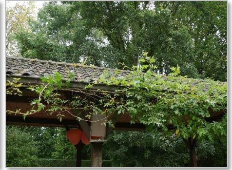
Te slopen aanbouw
