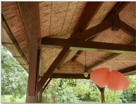
Te slopen aanbouw
