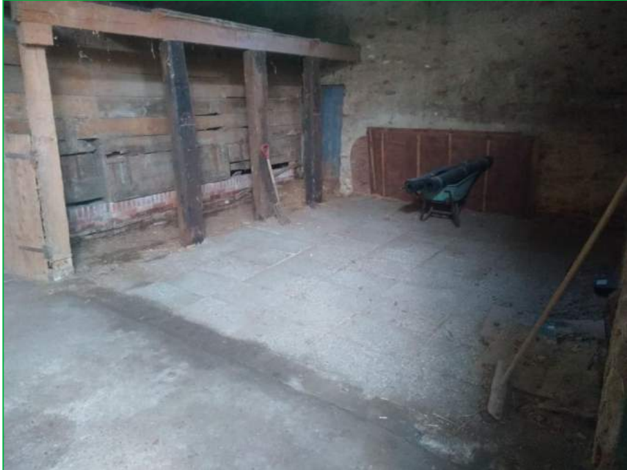
Foto 3. Deel van de schuur waar boring 02 is geplaatst.
