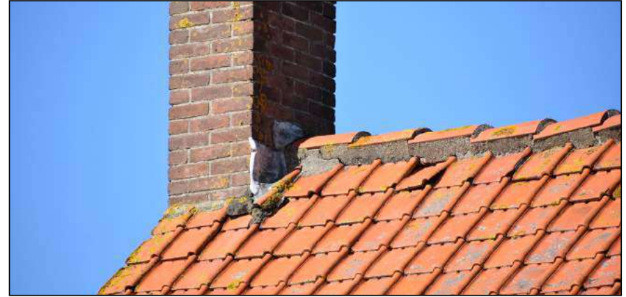
Figuur: op het dak van het woonhuis zijn losliggende of scheefgezakte dakpannen aanwezig waardoor vleermuizen, vogels zonder jaarrond beschermd nest en huismus ruimtes in het dak kunnen bereiken.
