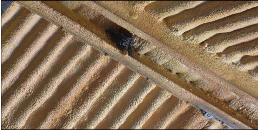
Figuur: de loods is van binnen geïsoleerd door een schuimlaag. Hierdoor zijn er geen ruimtes in het dak of in de muren aanwezig. Wel kunnen vogels zonder jaarrond beschermd nest hier tot broeden komen. Op de foto is een nest van boerenzwaluw te zien.
