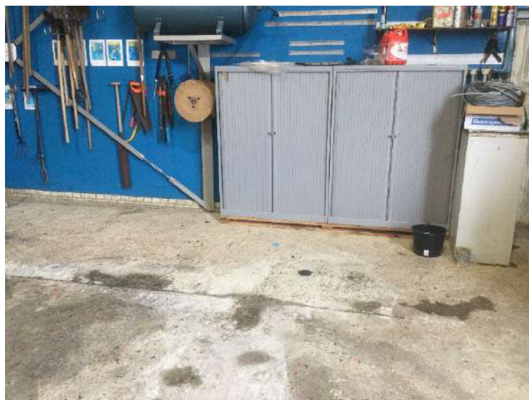
Foto 9 Locatie van de olieopslag in de stalenloods
