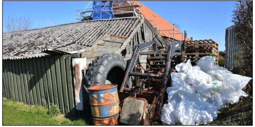
Figuur: op het terrein zijn losliggende materialen aanwezig. Hier kan rugstreeppad verblijfplaatsen hebben.
