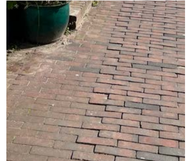
Gebakken klinkers waalformaat; type: Padova; halfsteensverband
