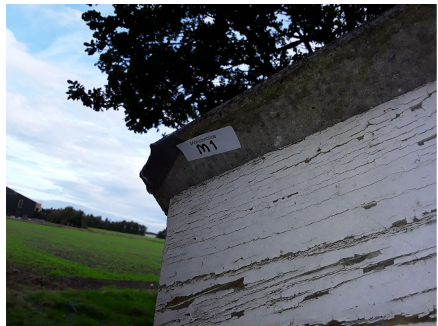
Dak: golfplaat (M1)
