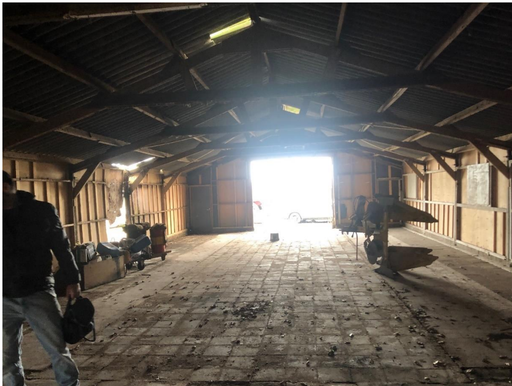
Figuur 4.4.2. De gevels en het dak zijn volledig enkelwandig.
