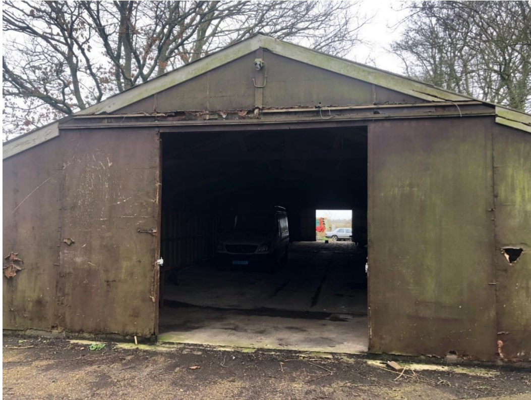
Figuur 4.4.1. De te slopen stal.
