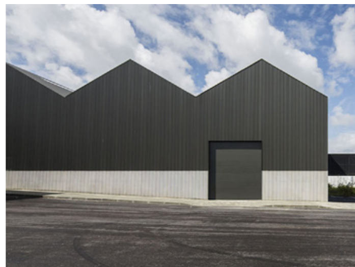
Nieuwe loods van beton en staal met eenvoudige vormgeving
