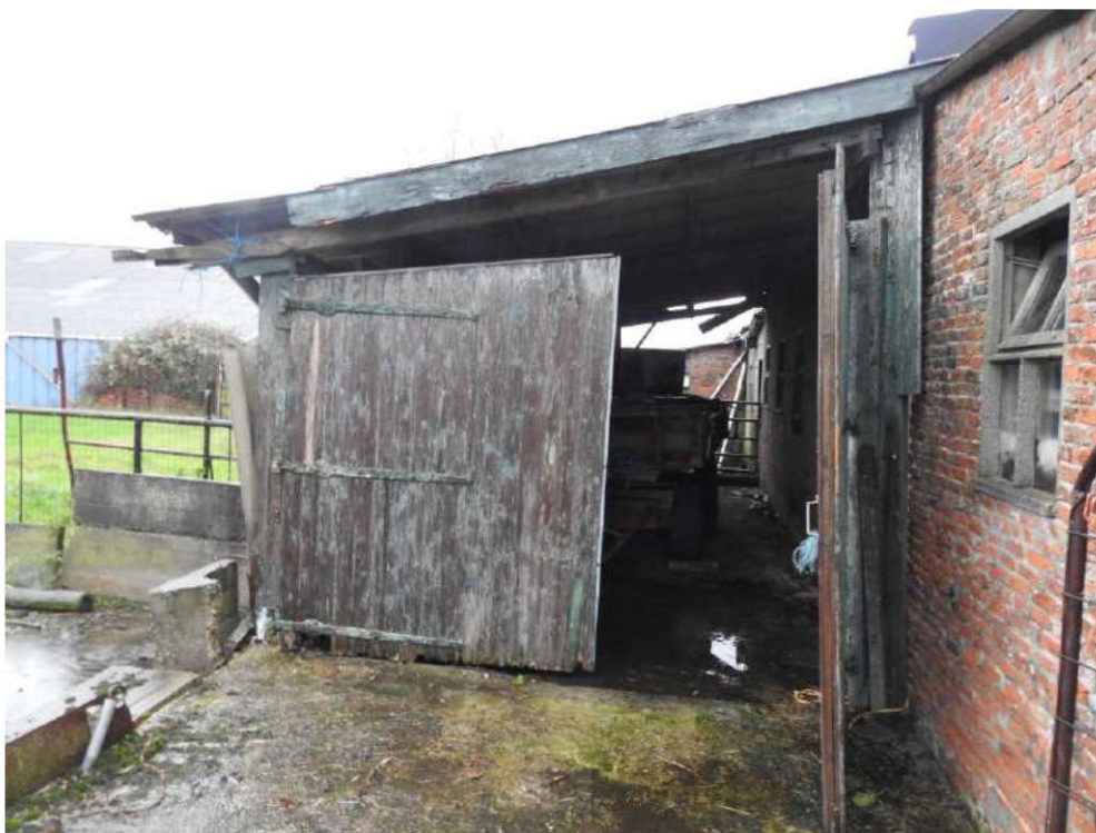
Foto 2. Plangebied, te slopen bebouwing.
