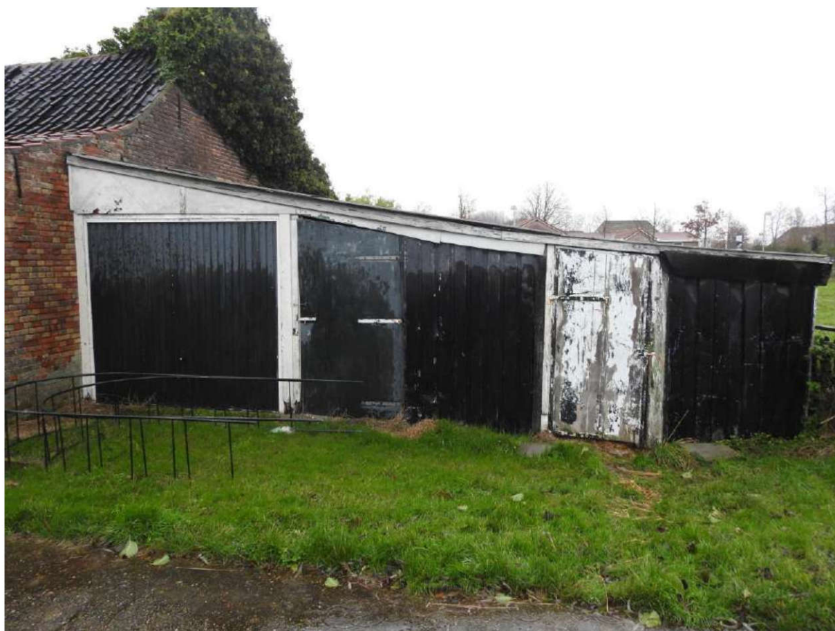
Foto 5. Te slopen bebouwing.
