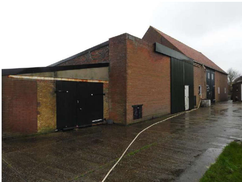
Foto 3. Te slopen bebouwing.
