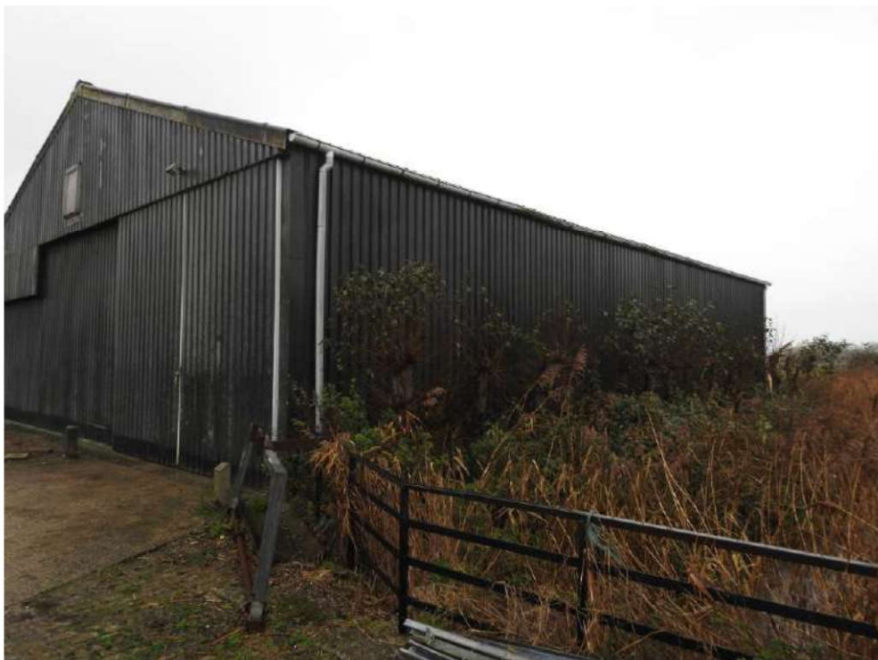
Foto 1. Plangebied, te slopen bebouwing.
