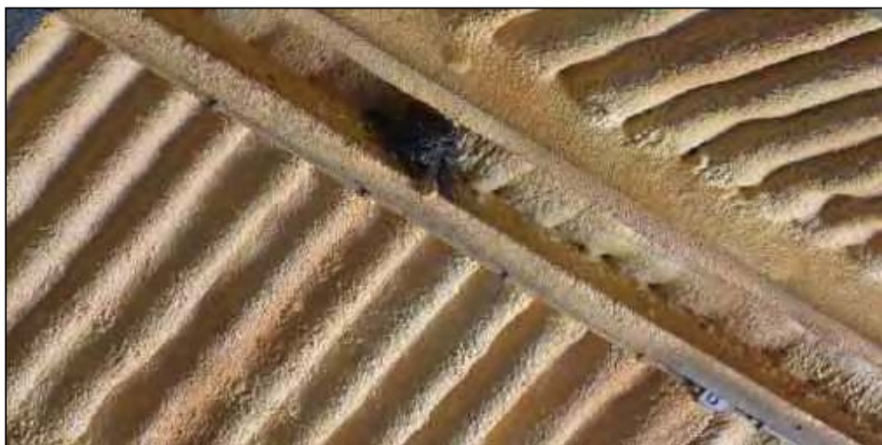
Figuur: de loods is van binnen geïsoleerd door een schuimlaag. Hierdoor zijn er geen ruimtes in het dak of in de muren aanwezig. Wel kunnen vogels zonder jaarrond beschermd nest hier tot broeden komen. Op de foto is een nest van boerenzwaluw te zien.
