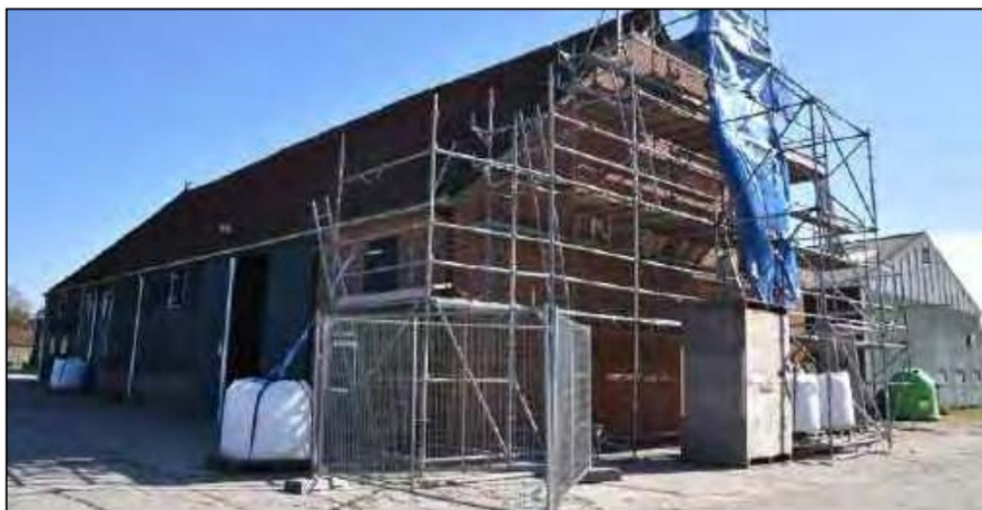
Figuur: op de voorgrond is de schuur te zien waarin zes appartementen gerealiseerd zullen worden. Op de achtergrond is de loods te zien die gesloopt zal worden.
