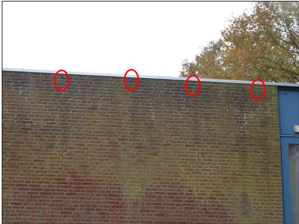
Rood omcirkeld de aanwezige stootvoegen aan deze zijde van het gebouw.
