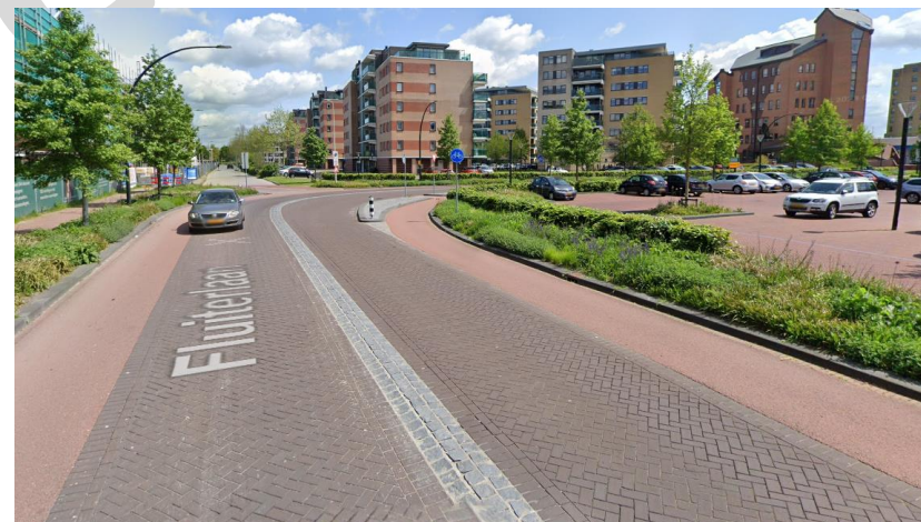
Profiel met klinkerstrook (en fietsstroken)
