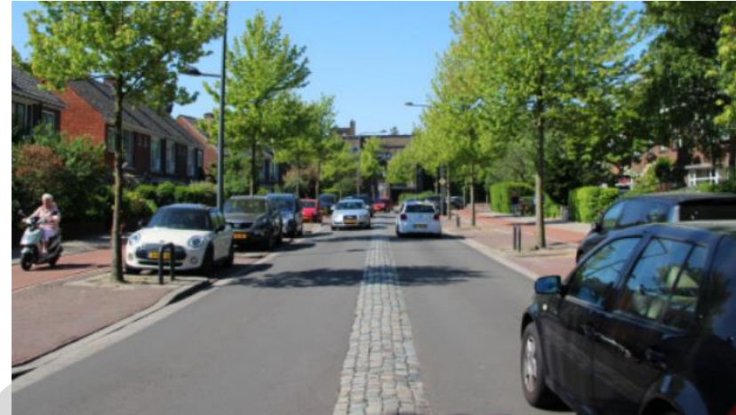
Rijrichtingscheiding door middel van een klinkerstrook
