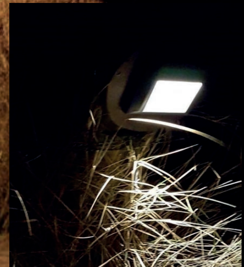
Dit eenvoudige armatuur is uitstekend geschikt voor oriëntatie en richt het licht naar beneden zodat uitsluitend een beperkt gebiedje op of aan de rand van het kampeerveld verlicht wordt
