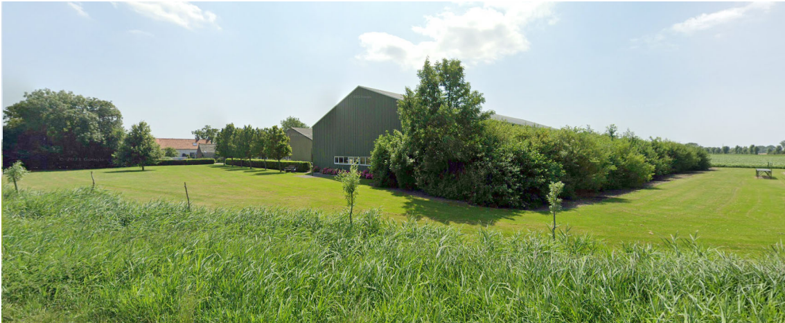
Figuur 3.1. Zicht op het agrarisch bedrijf Noordweg 3 ten zuidwesten van het plangebied (bron: Google Streetview)
