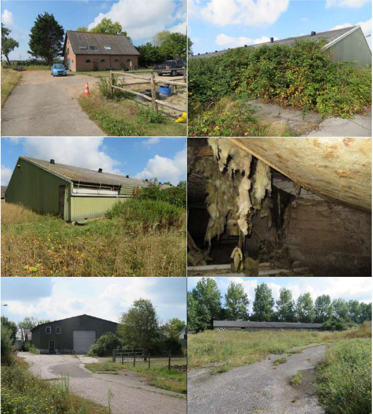
Afbeelding 4 - 9: foto-impressie plangebied. Vlnrvnb: Gebouw 2, buitenkant gebouw 3 2x, binnenkant gebouw 3, buitenkant gebouw 5 en buitenkant gebouw 5.
