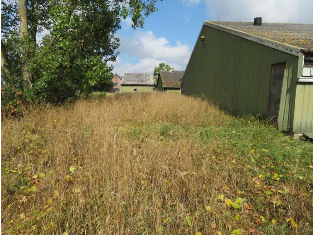
Daken verschillende gebouwen
