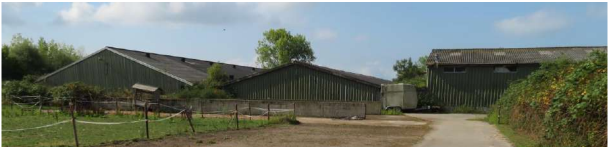
Daken verschillende gebouwen
