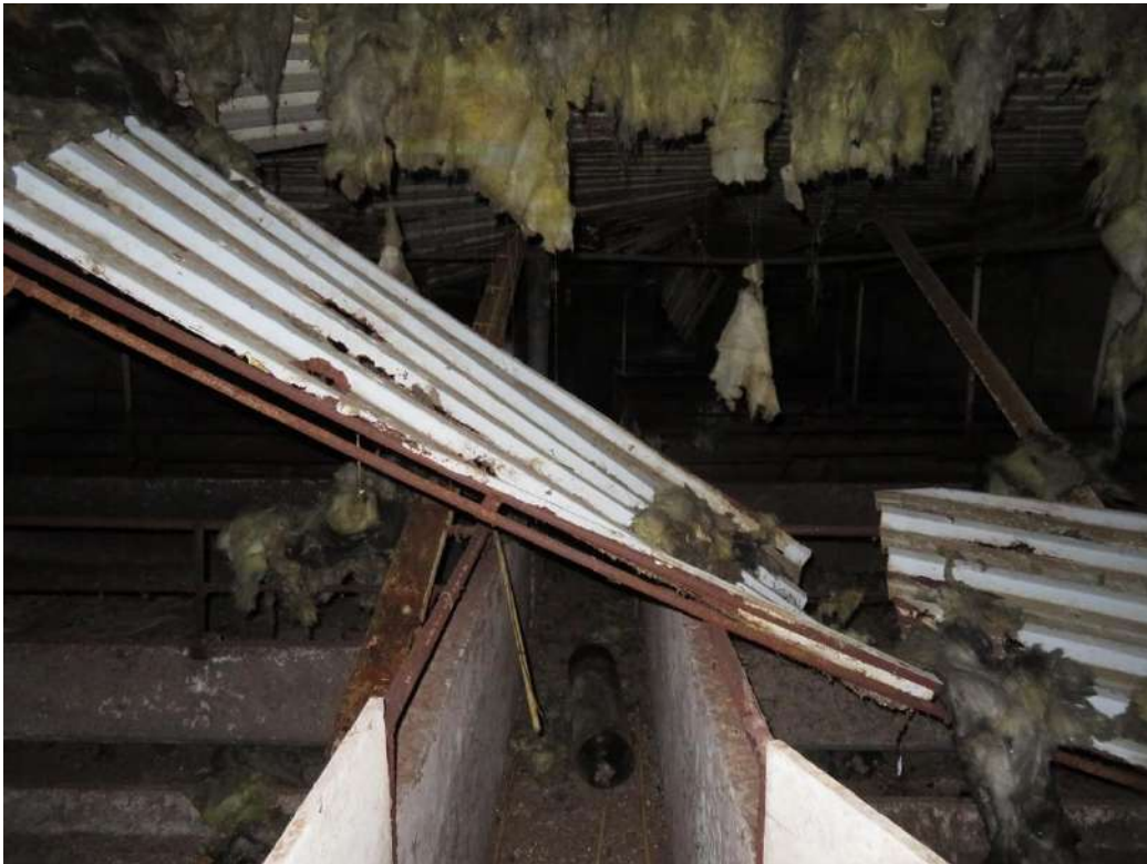
De toestand van de binnensituatie in gebouw(en) 3.
