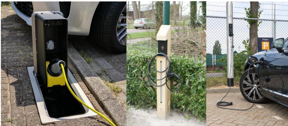
Figuur 11: Voorbeelden voor esthetische laadpalen: Streetplug (links), van hout (midden) en verwerkt in het straatmeubilair (rechts)
