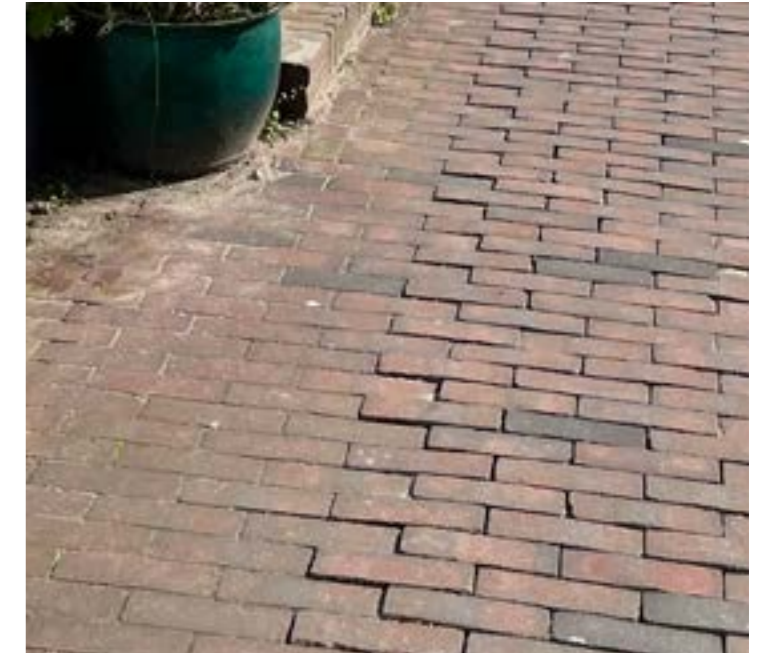
Gebakken klinkers waalformaat; type: Padova; halfsteensverband
