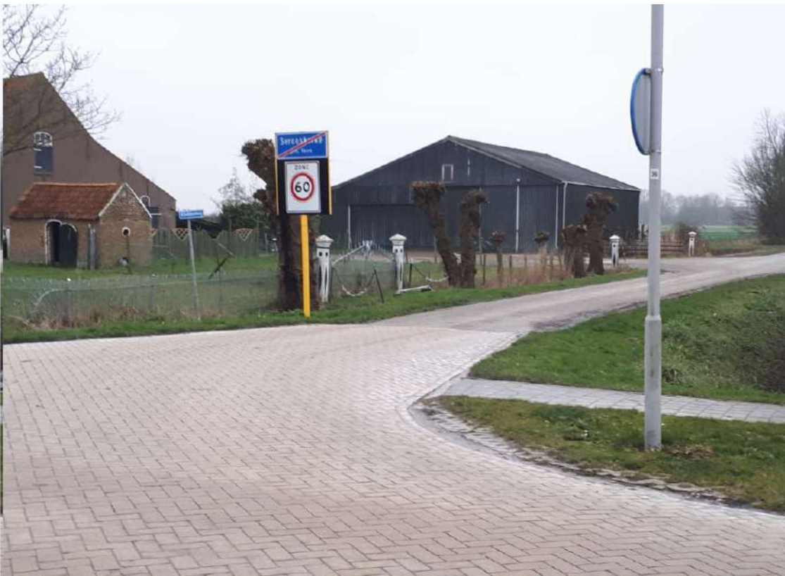
Figuur 2.1 De damwandloods is een ontsiering van de entree van Serooskerke
