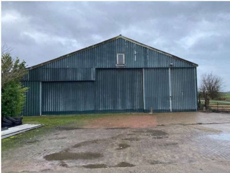
Figuur 2.4 Voorzijde van de agrarische damwandloods
