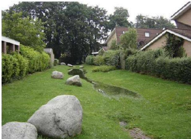
Afbeelding: Wateropvangreservoir (Wadi) in een woonwijk
