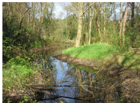
Bestaande wadi voor waterberging, retentie en infiltratie in combinatie met versterking biodiversiteit.
