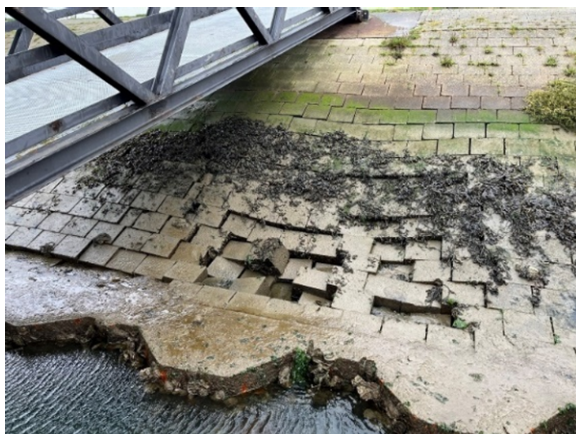
Afbeelding: de aantasting van het talud zet verder door
