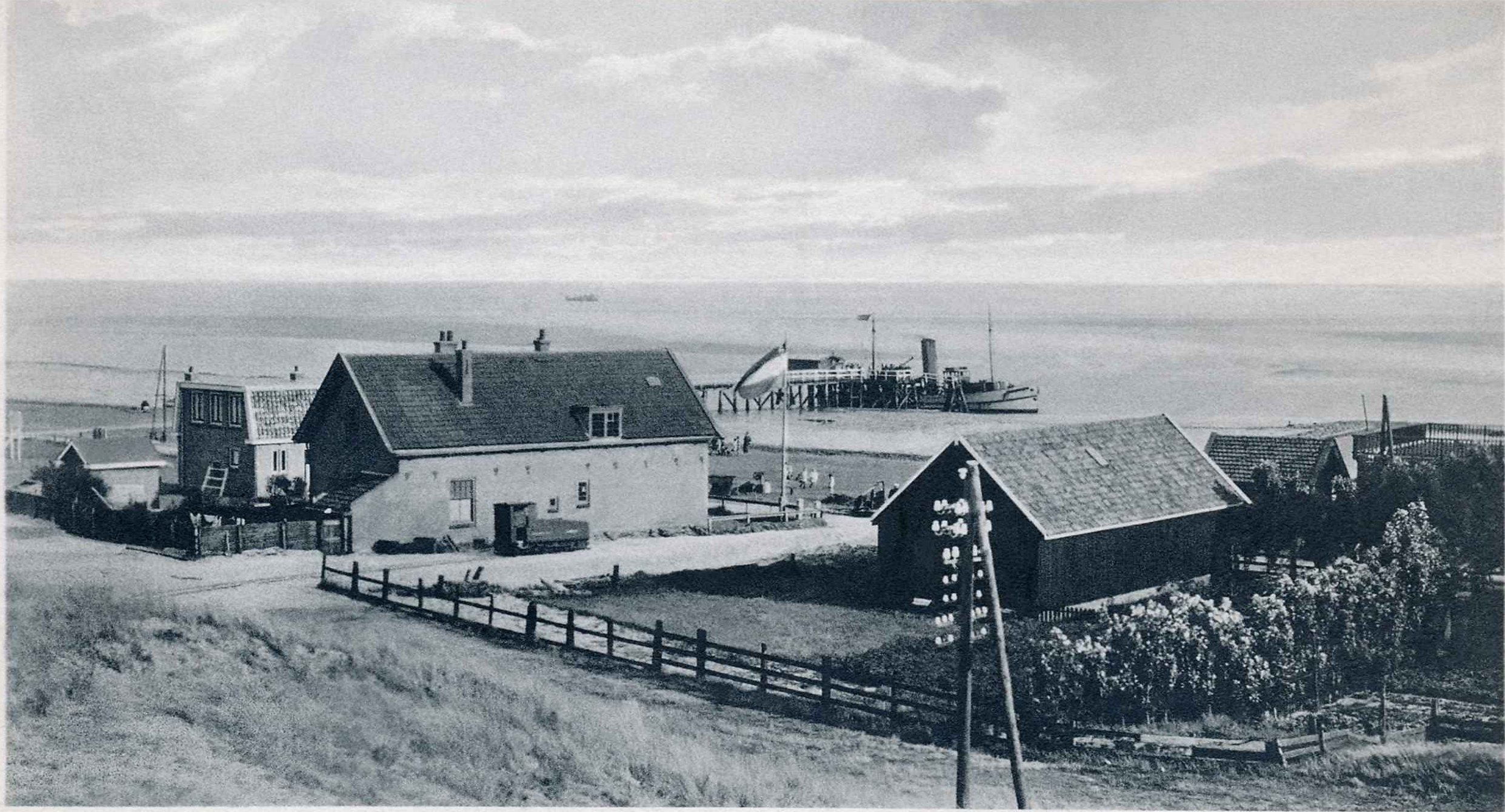
Aanlegplaats met stortemelk — Vlieland
