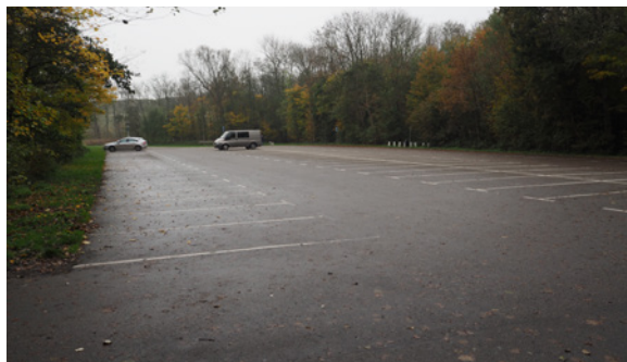
asfaltparkeerplaatsen heten je 'welkom'
