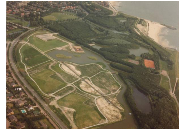
het Westduinpark tijdens aanleg
