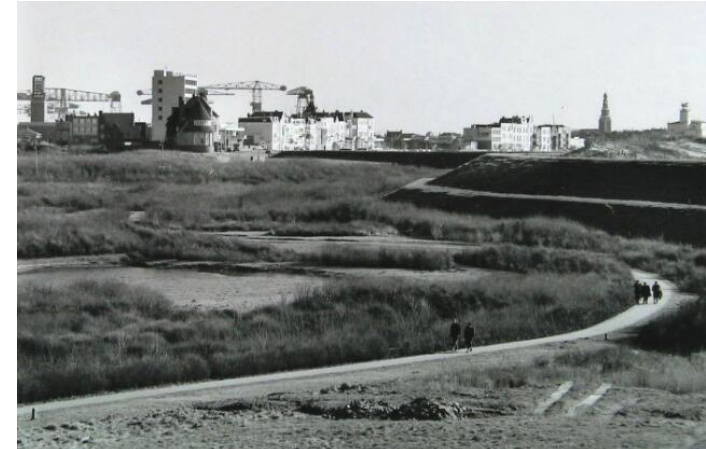
het Nollebos tijdens de aanleg
