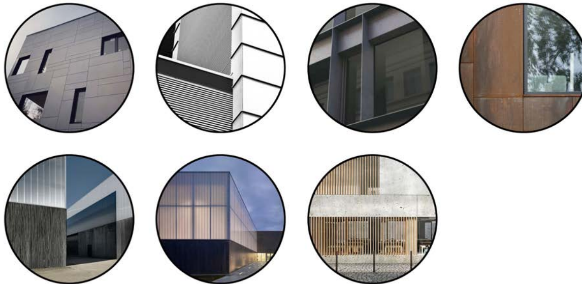
Wereld van de Binnenhavens-De Maritieme pier materiaalpalet: Materialen bestaan uit prefab betonpanelen in grijs tot antraciet, thermisch verzinkt staal in aluminiumkleur, cortenstaal, keramische platen, roestbruine metalen beplating, aluminium, glaspanelen of materialen met gelijke uitstraling.
