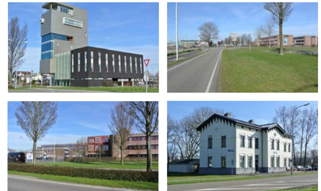
Huidige situatie Wereld van de Prins Hendrikweg-Campuszijde
