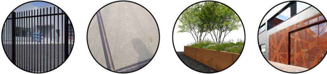
Wereld van de Binnenhavens-De Watersportpier erfafscheidingen en materialisering openbare ruimte: open spijlenhekwerken, semitransparante afscherming buitenopslag, grasbetontegels en betonplaten.
