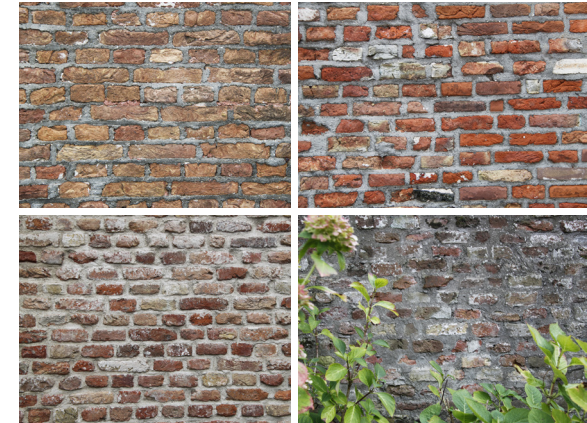
bruine en rode bakstenen zijn de gebruikelijke metselstenen in de omgeving
