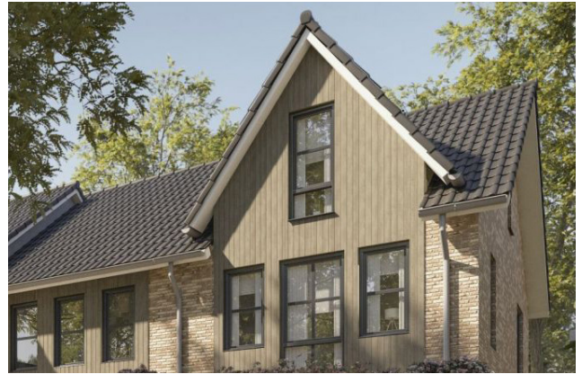
Figuur 16: Combinatie van hout en metselwerk
