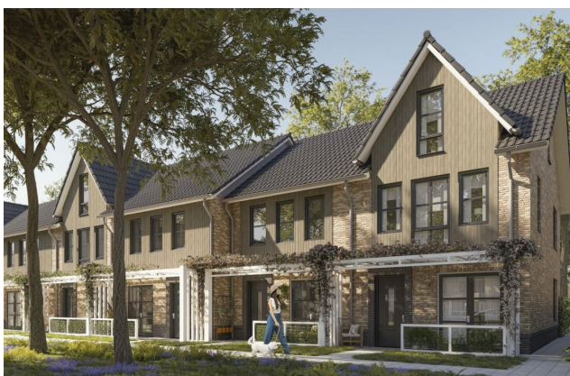
Figuur 6: Rijteswoningen met een mix van hout en metselwerk
