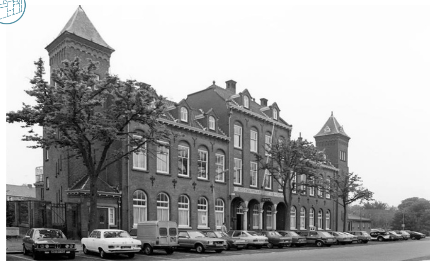
Het voormalige Postkantoor
