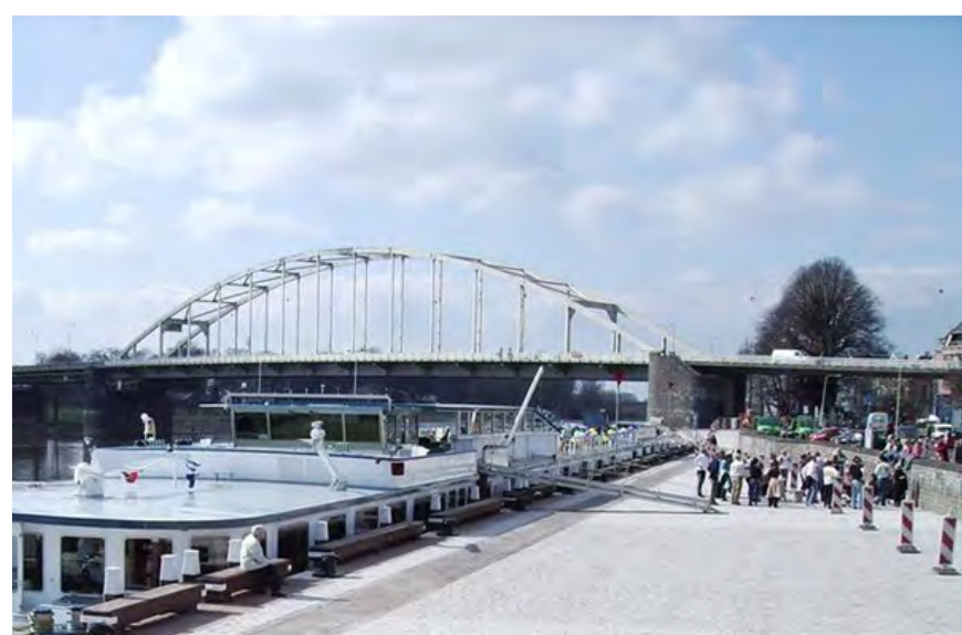
Referentie: aanlegplaats riviercruiseschepen
