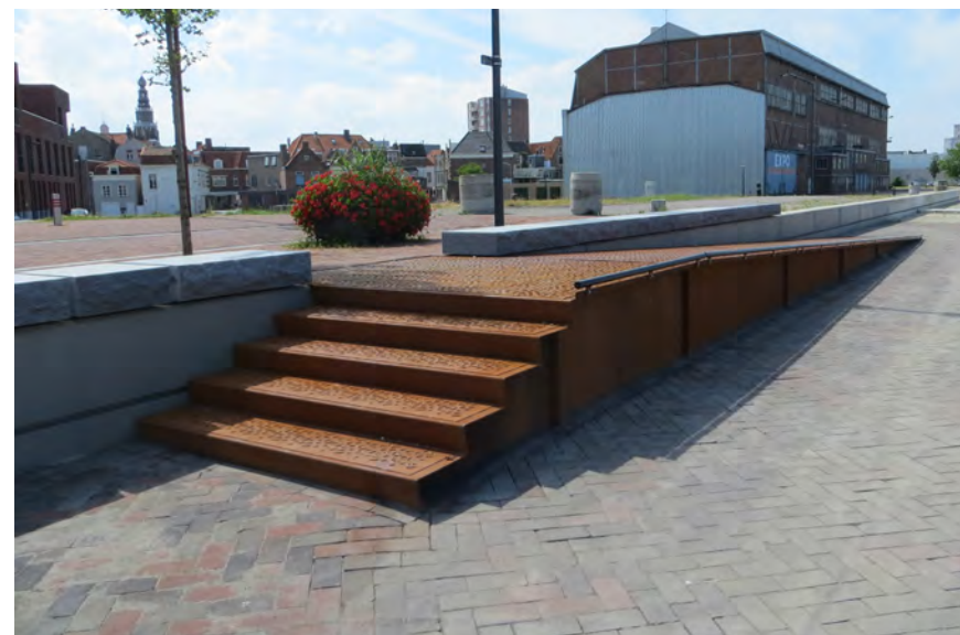
Bestaande eigentijdse cortenstalen inrichtingselementen rondom het Dok
