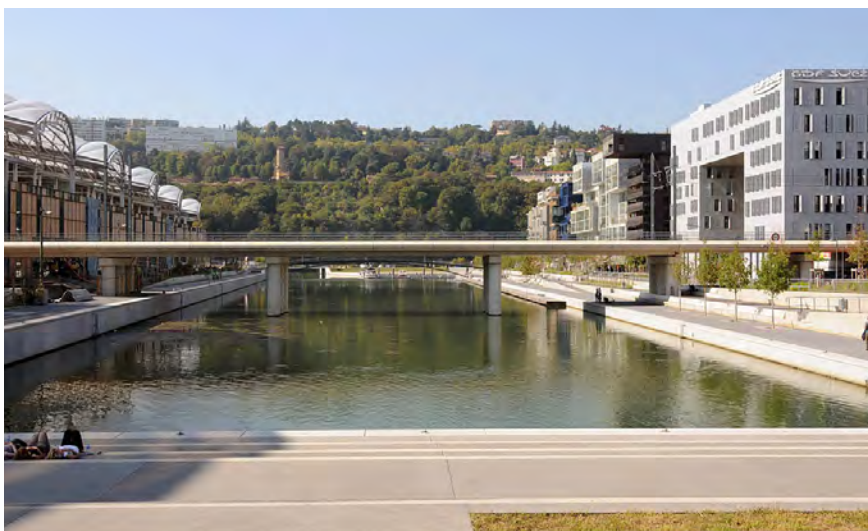
Referentie: totaalinrichting rondom Dok (van kades en waterkering) d.m.v materialisatie en inrichting
