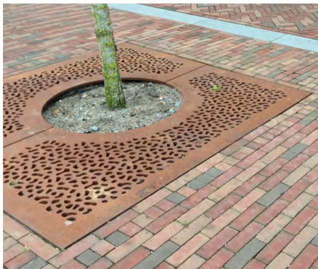
Boomroosters met zuiliepen op de hoge kade (reeds gerealiseerd)
