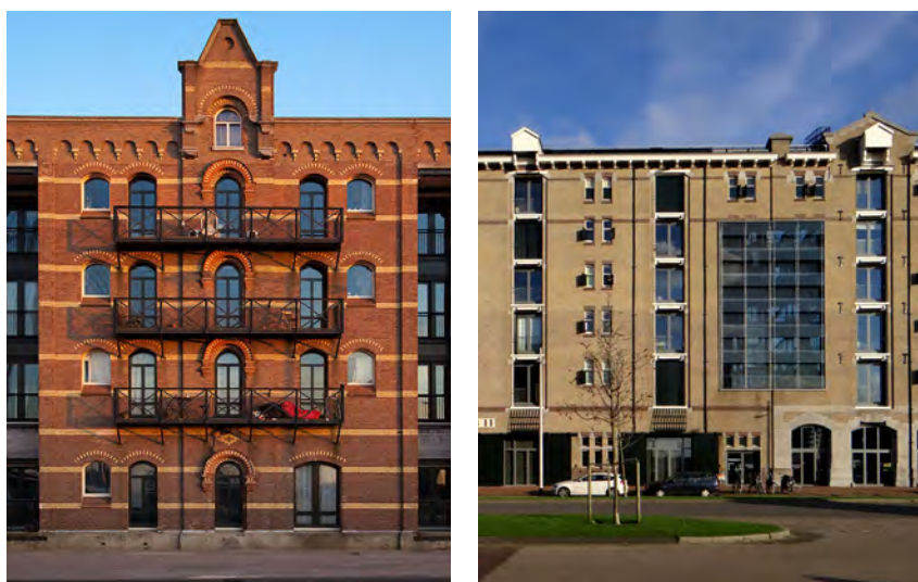
Referentie: afwijkende materialisatie van de balkons (staal vs baksteen) of inpandige buitenruimte
