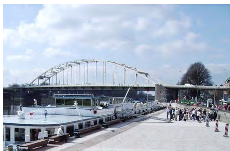
Referentie: aanlegplaats riviercruiseschepen
