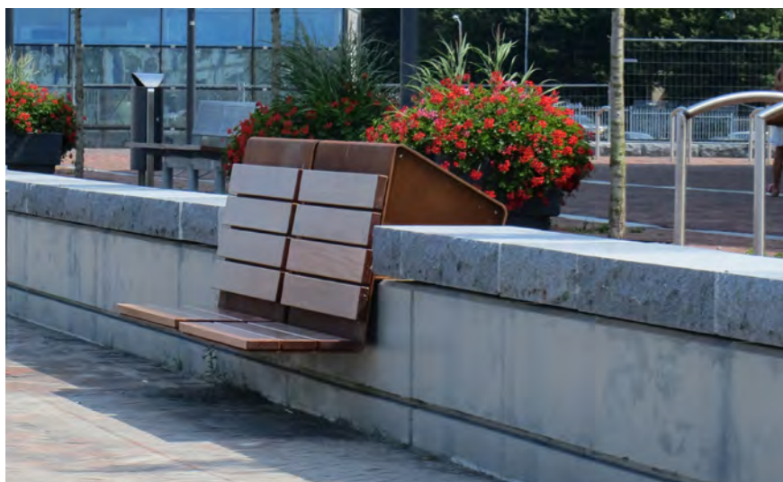
Bestaande keermuur, met eigentijds vormgegeven zitelementen
