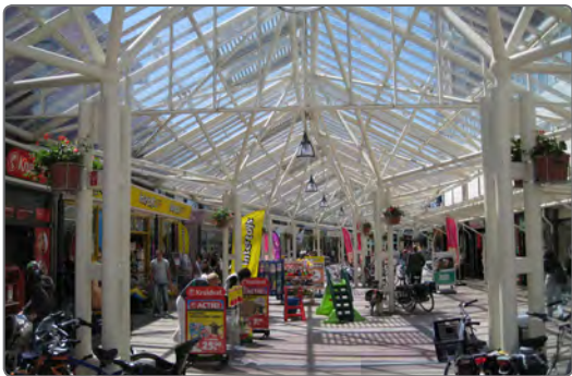
Project: luifel en uitstallingen Lange Zelke
