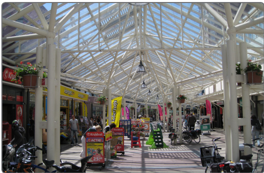
Project: luifel en uitstallingen Lange Zelke
