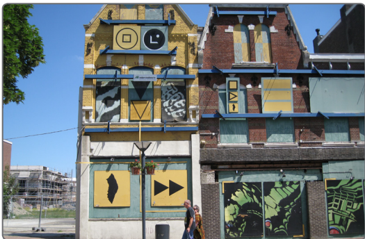
Project: invullen winkelwand Kleine Markt met trekker
