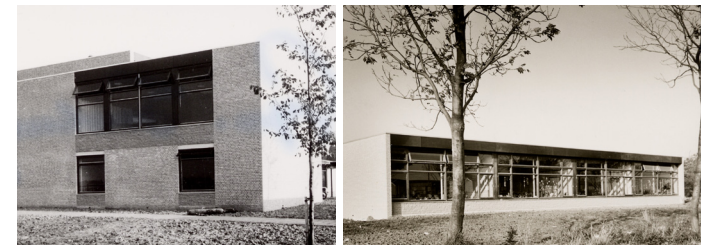
Eenvoud van de bestaande bebouwing
