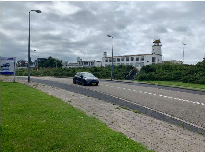
Spuiikomweg met zicht op voormalige Zeevaartschool
