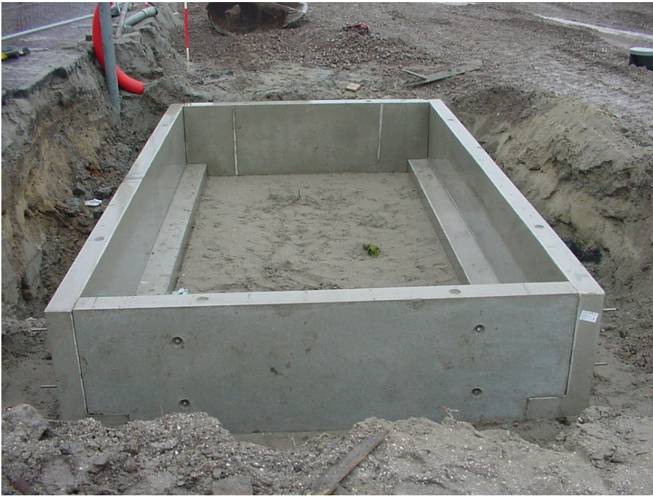
Afbeelding boombunker (zonder afdekplaat)
