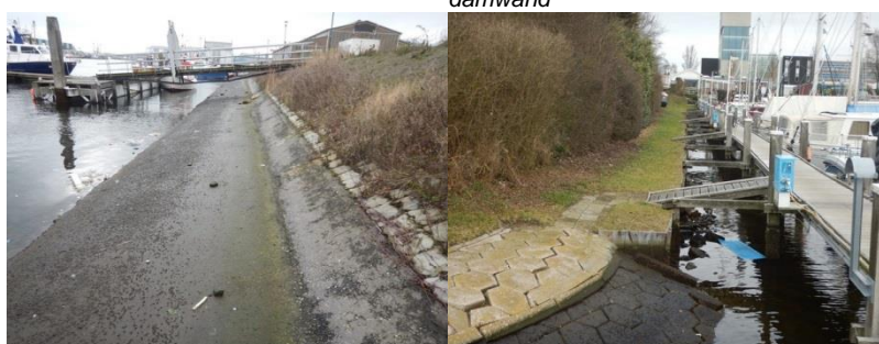
Oeverconstructie zetsteen + waterbouwasfalt
