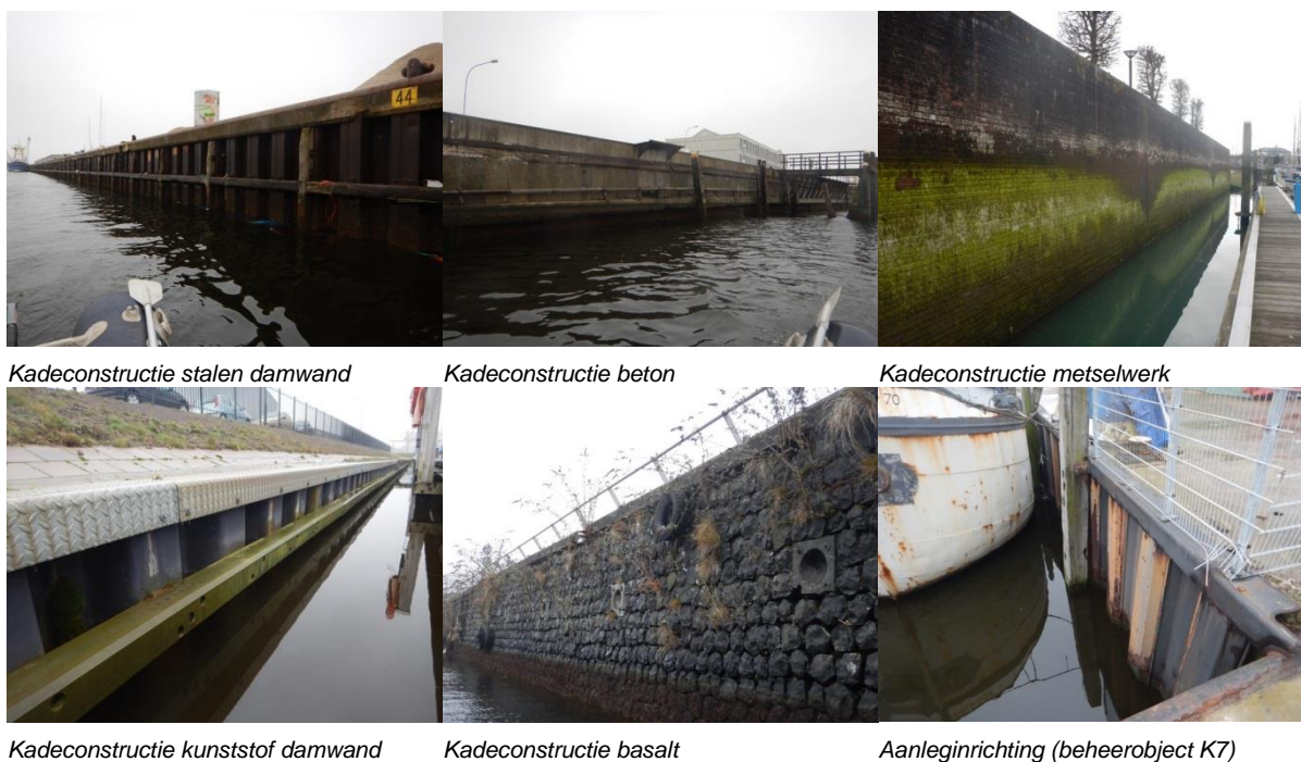
Figuur 2-2: Overzicht kadeconstructies
