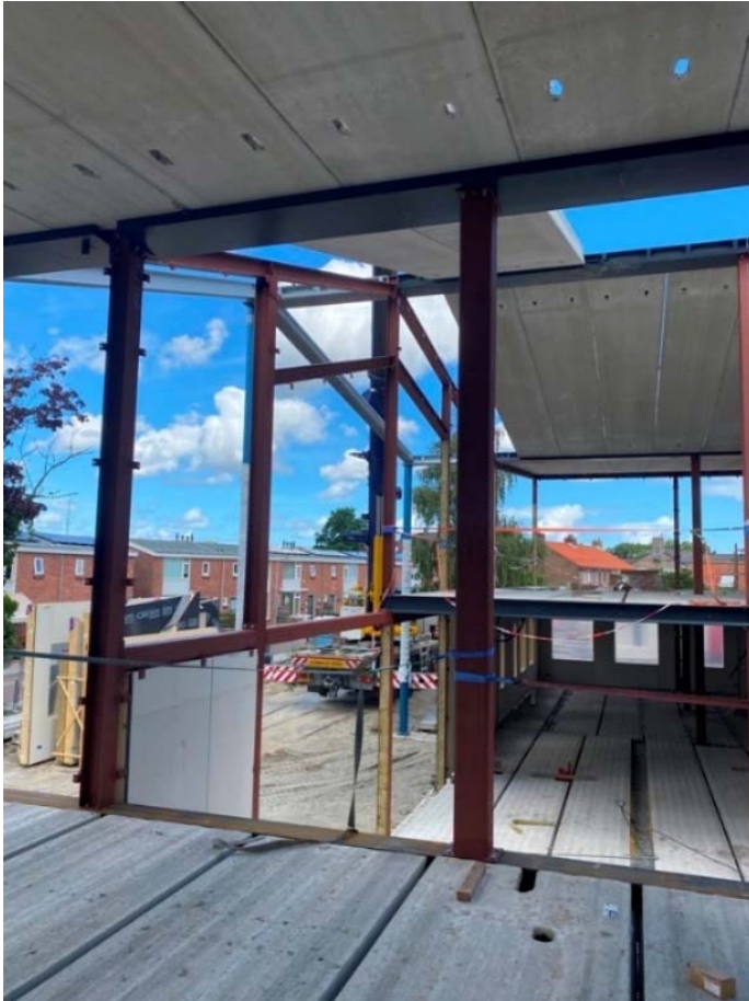
figuur 11: Foto van uitvoering zonder tijdelijke stempels
