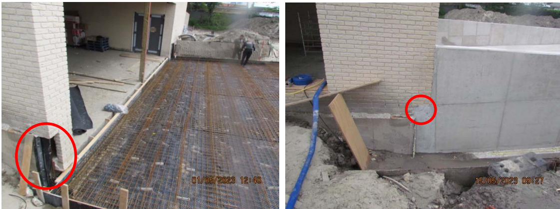
figuur 10 Foto's van uitvoering hellingbaan met markering aansluiting metselwerk.
