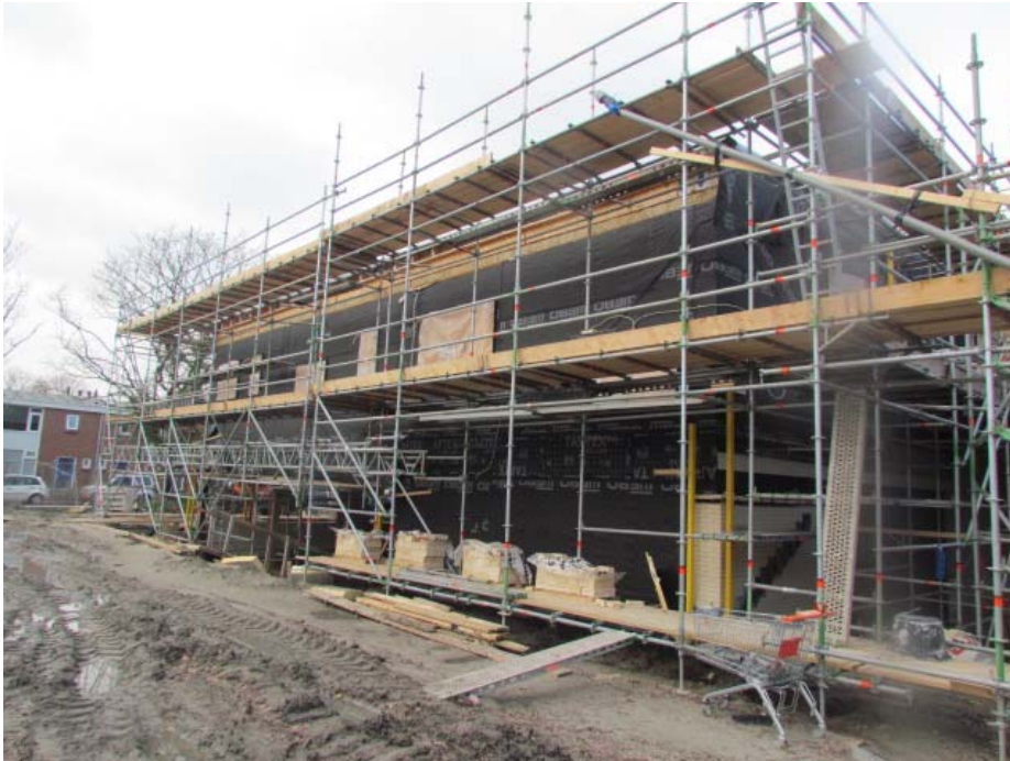
figuur 7 Foto van de uitvoering, waarop (zwarte) waterkerende laag is te zien.
