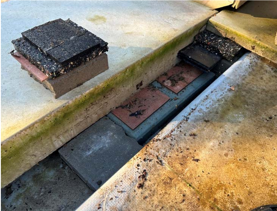
figuur 5 Oplegging tribune met (rodebruine) kunststof oplegplaten op tegel met een breedte van 40 cm.
