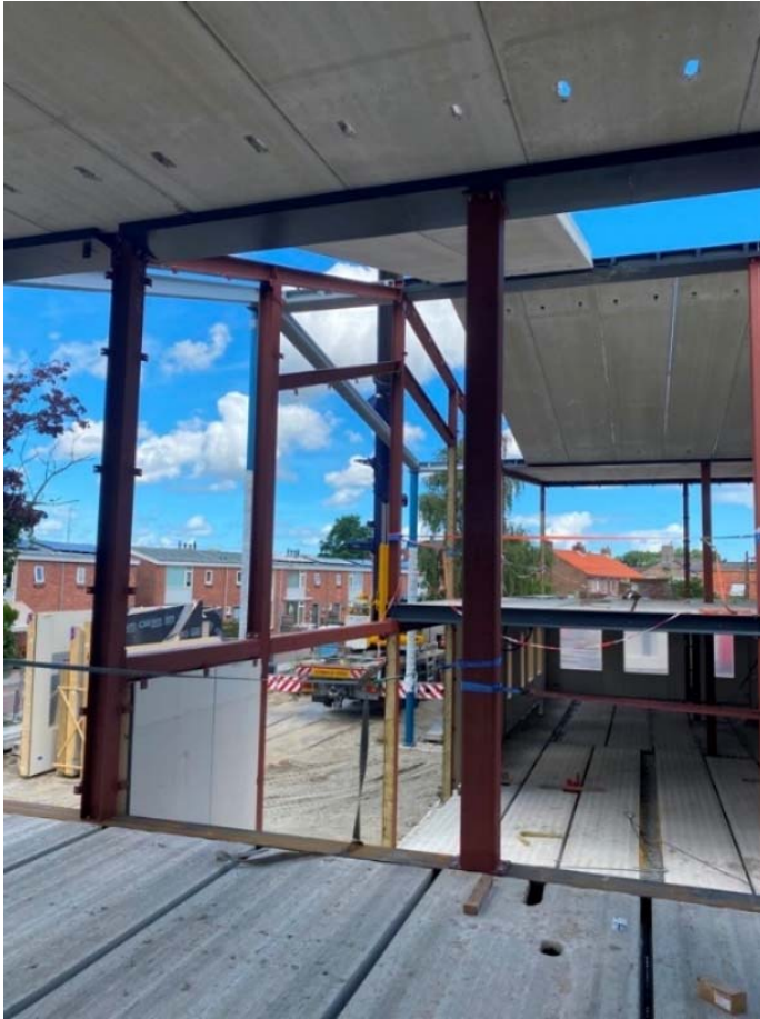
figuur 13: Foto van uitvoering zonder tijdelijke stempels
