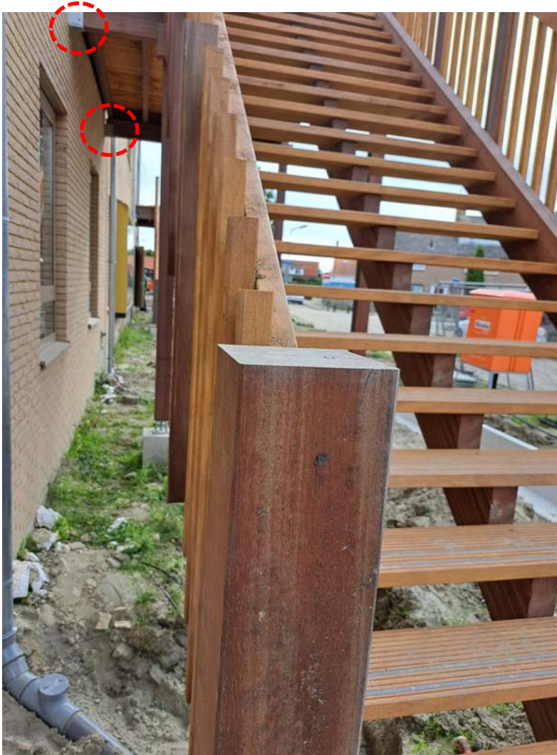
figuur 7: bevestigingen houten bordes aan gebouw (rood gemarkeerd)
