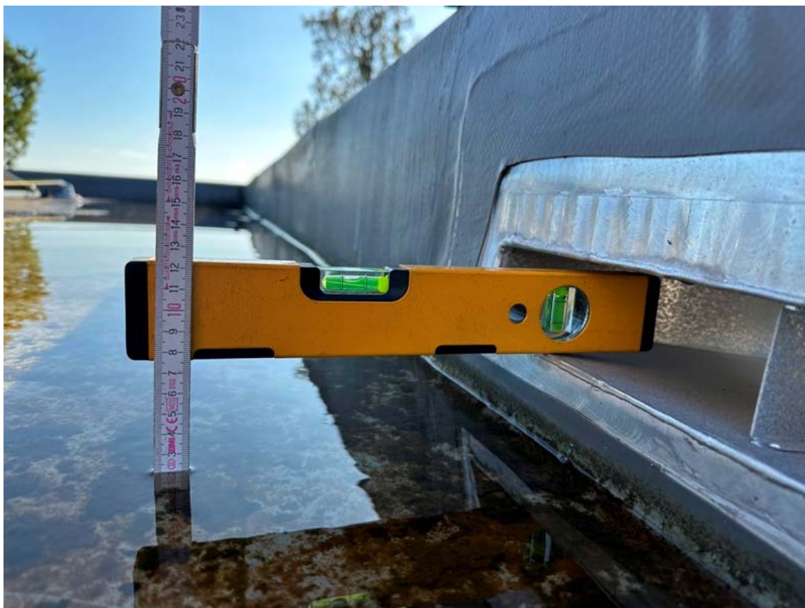
figuur 10: Inmeting drempelhoogte van noodafvoer (circa 75 mm)
