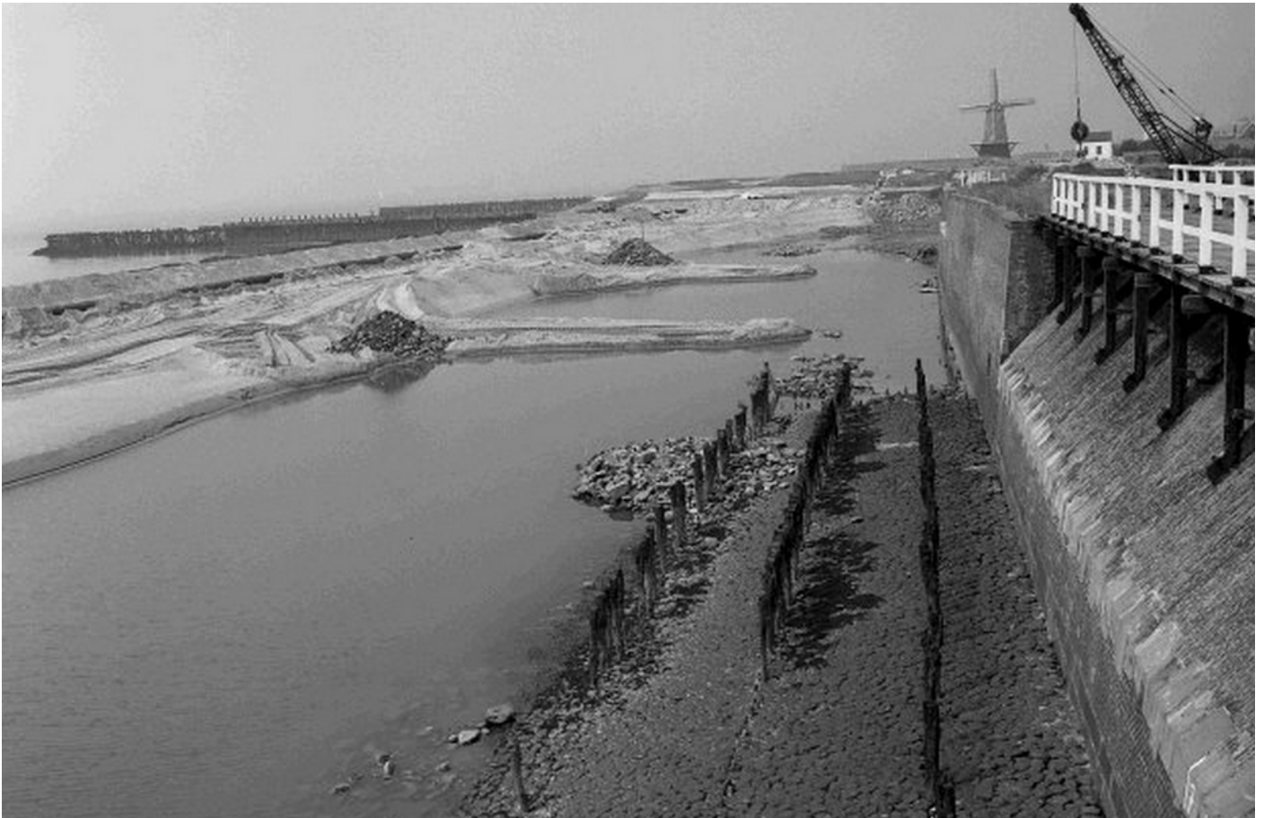
Situatie tijdens de bouw nieuwe zeewering
