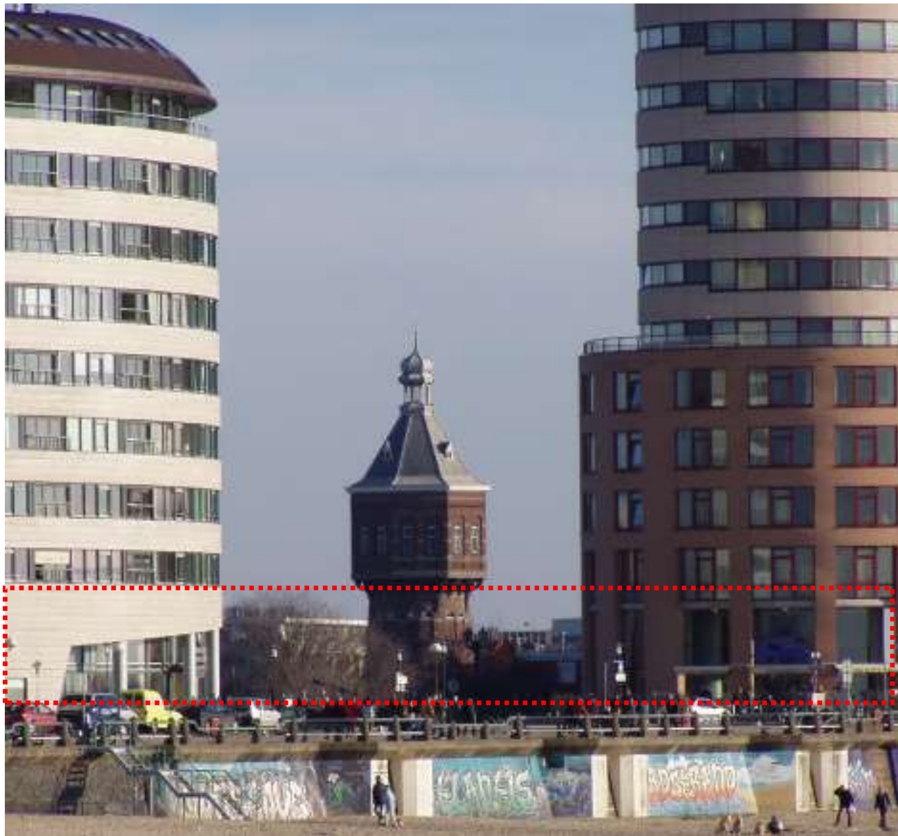
In rood omkaderd de dubbele verdieping op de begane grond
