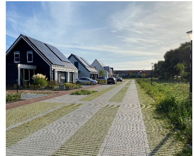
> Figuur 7: Een klimaatadaptieve inrichting van de buitenruimte wordt steeds belangrijker. Een goed voorbeeld is dit onlangs aangelegde 'Karrespoor' in de wijk Claverveld dat veel meer water doorlaat dan een reguliere weg.
