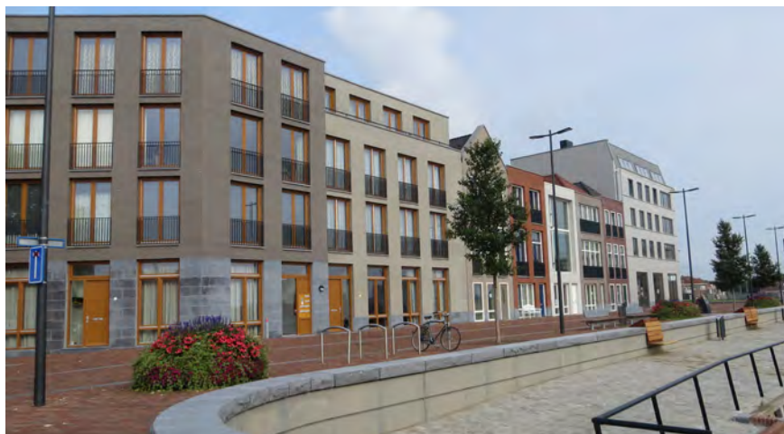
Referentie: bestaande inrichting van de Peperdijk
