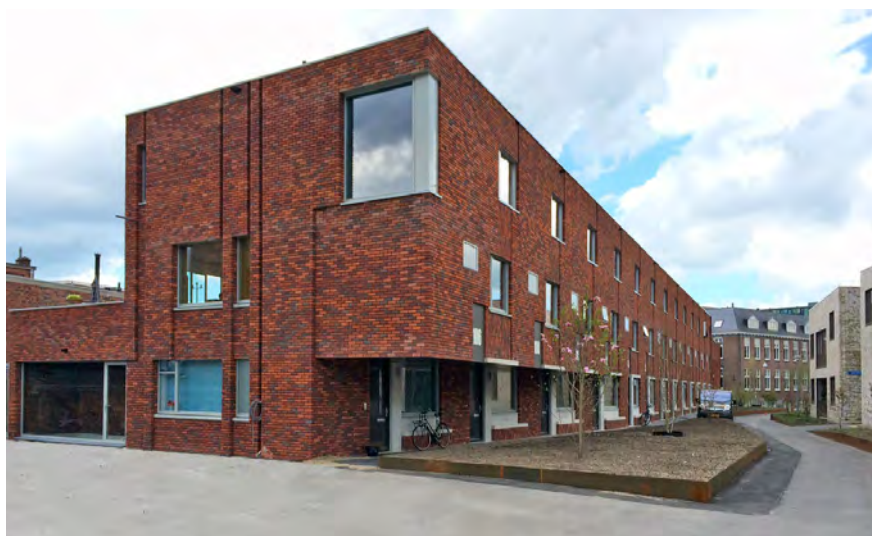
Referentie: ramen in de kopgevel als hoekoplossing en geïntegreerd bijgebouw met entree naar het openbaar gebied
