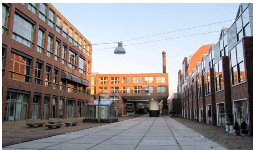
Referentie: verharding binnen het blok sluit aan op de openbare ruimte
