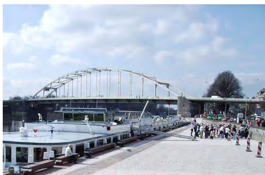
Referentie: aanlegplaats riviercruiseschepen
