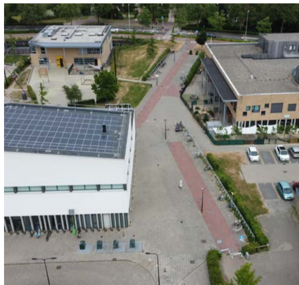
Heel stenig met een onduidelijk routing voor de verschillende modaliteiten
