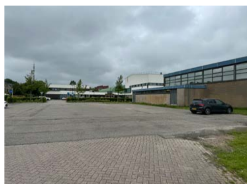
Verharde parkeerplaats naast gymzaal de Reede. Verrommelde uitstraling van het materiaal.
