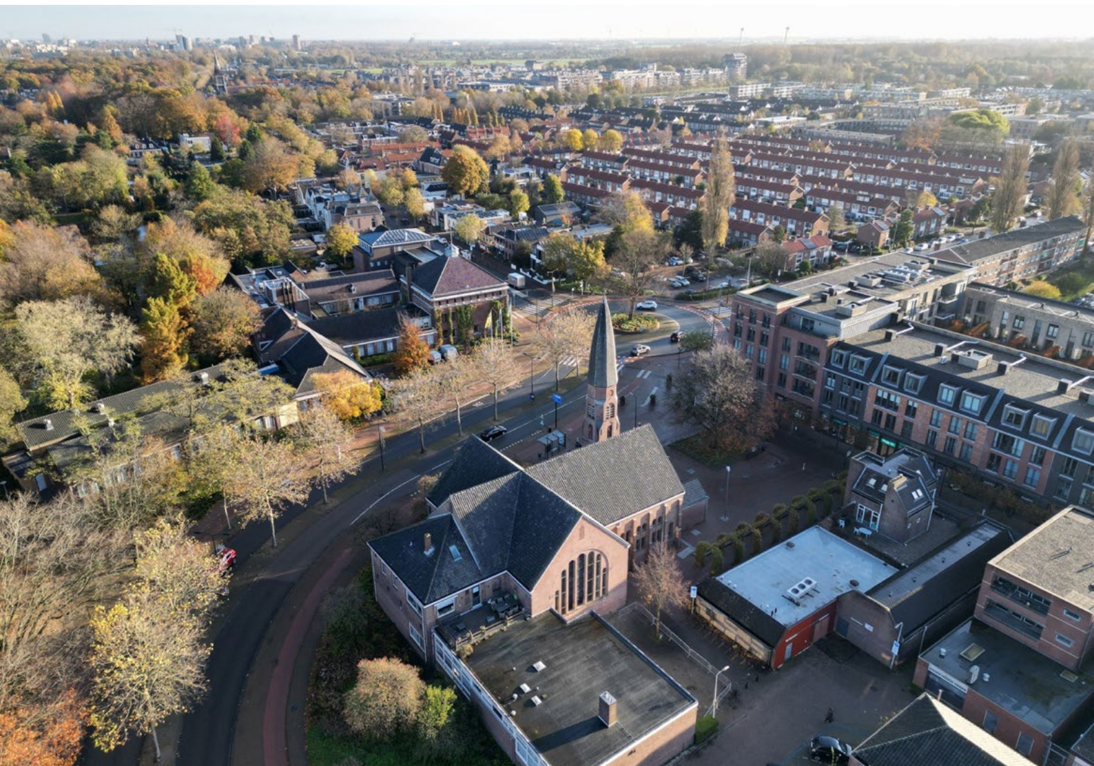
Luchtfoto Kruispuntkerk gezien naar het gemeentehuis (foto Aeriallive 2022).
