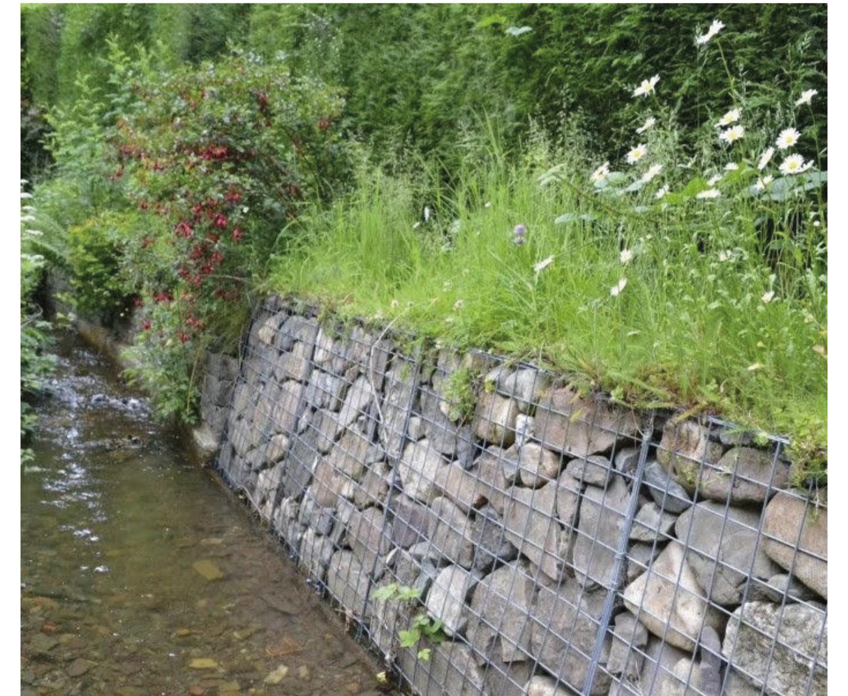
Referentie | Schanskorven aan het water langs de Leidseweg
