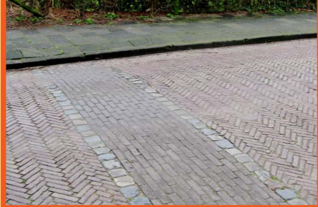
Afwijkende bestrating op de plaats van de Romeinse stadsmuur in de Arentsburghlaan te Voorburg (foto: Communique, Voorburg).
