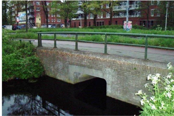
Foto 1 Leuningconstructie van duikerbrug
