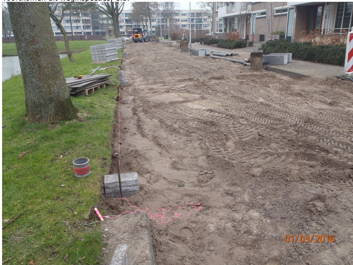
Voorbeeld van groot onderhoud waarbij de rijbaan geheel herstraat wordt
