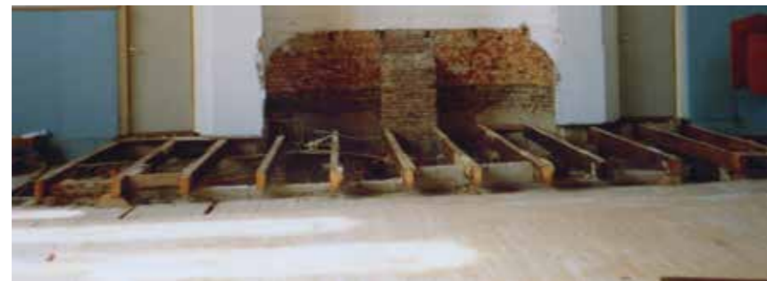
De vloeren, die precies tussen de muren pasten, waren gemaakt van lokaal gezaagd schroot, 14 cm breed, en de dakdelen waren bedoeld om buitenlandse gezaagde delen te bedekken, alles van eerste klas kwaliteit.
