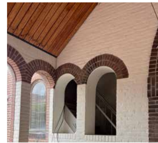
Originele kerkgevel is wit geverfd. Ramen zijn verwijderd waar de huidige openingen zijn.
