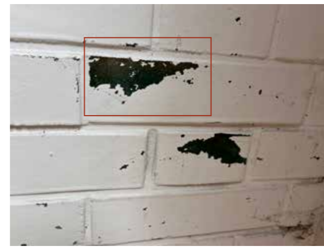
Groene tegels in zijportalen. Afgewerkt in beide portalen heeft een positieve monumentale waarde.
