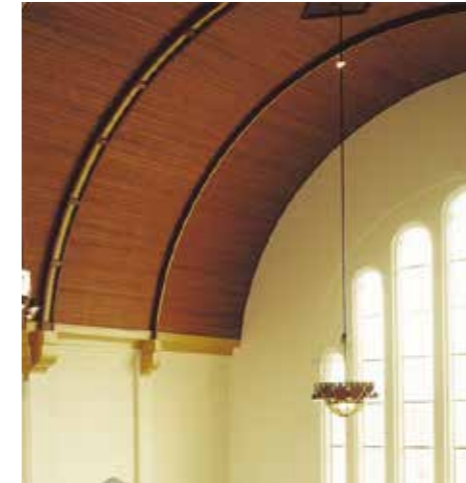
Dennenplafonds met kleine gebreken. Geschilderde gewelvbalken. Donkere lak en eikenkleur.
