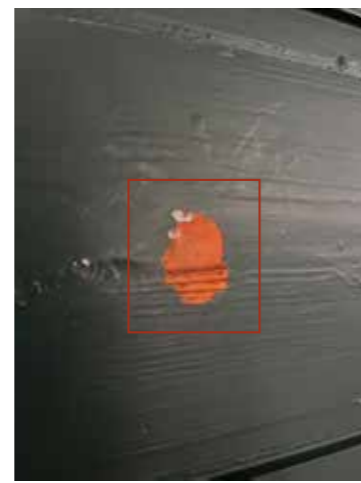
Plafond van grenenhout zichtbaar onder twee lagen verf.
