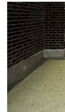
Alle portalen hebben een gegoten betonnen vloer met Granito erop.
