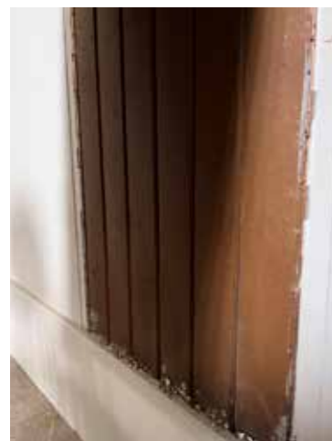
Originele wandpanelen onder bestaande wandpanelen.
